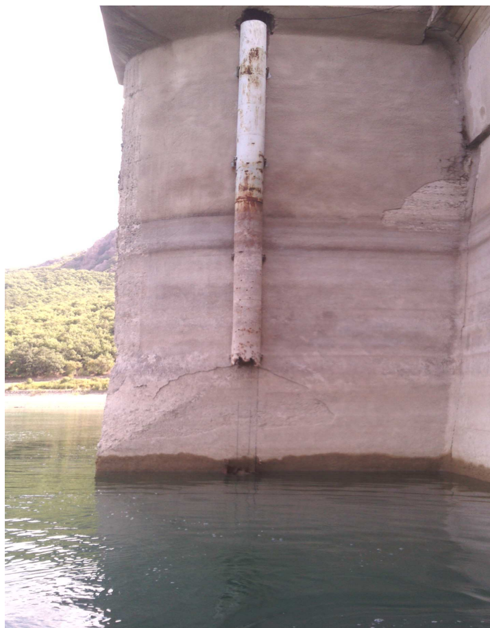
Общ вид на нивомерна тръба и кабина №10 – ГРТ преливни клапи
